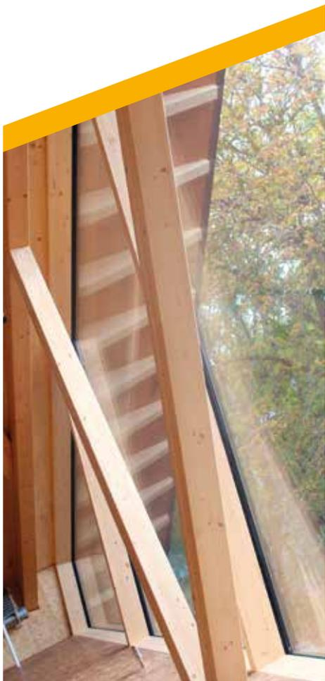
Les poutres en lamellé-collé fabriquées dans nos usines sont destinées au marché de la construction. C'est un procédé qui permet d'augmenter la résistance mécanique du bois.
